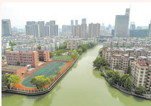
4月，市区横渎河东岸绿道贯通提升工程通过竣工预验收，面积为11630平方米，全长750米，大幅改善了片区整体颜值和品质
